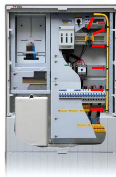
Ukázka uchycení ASES-TS v el. skříní
